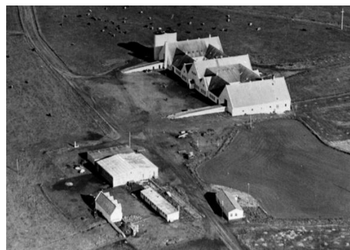
Mynd 12. Horft yfir nýja bæjarstæði Korpúlfsstaða. Rafstöðvarhúsið er neðsta húsið til hægri. 27
