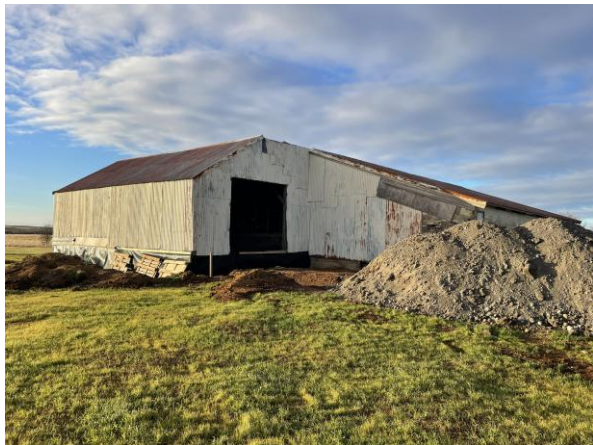
Mynd 4. Núverandi fjárhús á Ærhúsbakka, horft til suðvesturs.
