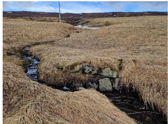
Mynd 68. Hleðsla [3417-116]. Horft er til NV.
