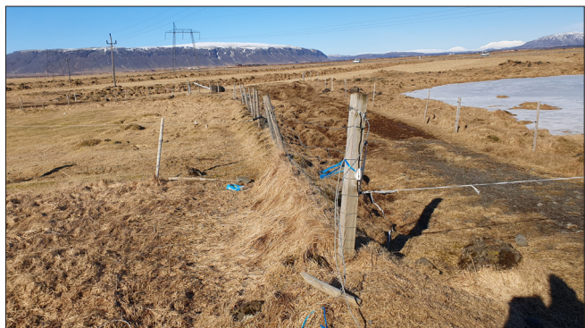
Mynd 17: Túngarður ÁR-046:005, horft til norðvesturs.
