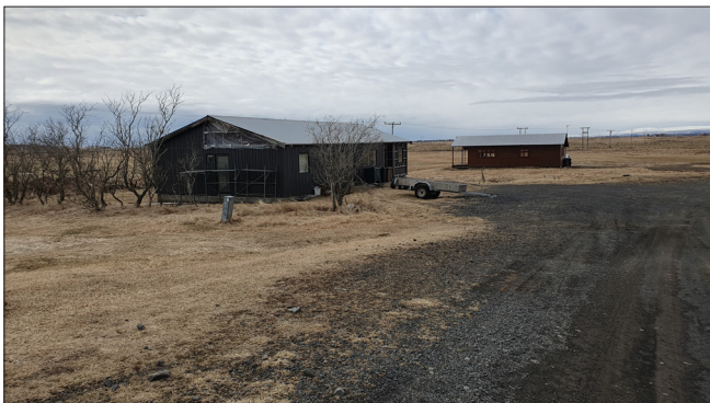
Mynd 13: Bæjarhóll Starkarhúsa ÁR-042 er við og undir íbúðarhúsi, byggt um 1980.
