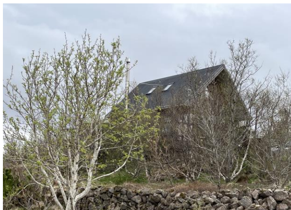
Mynd 5 – Sumarhús byggt 1999
