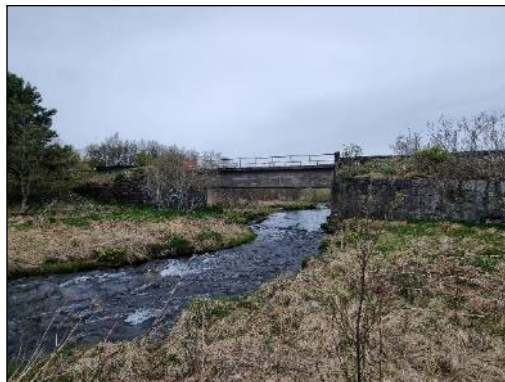
Mynd 14. Elliðaárbrúin yfir vestari kvíslina, horft í norður.
