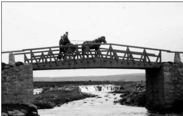
Mynd 13. Brúin yfir vestari kvíslina um 1910. Í baksýn er Búrfoss. Burðarbitar, brúargólf og handrið úr timbri. 32
