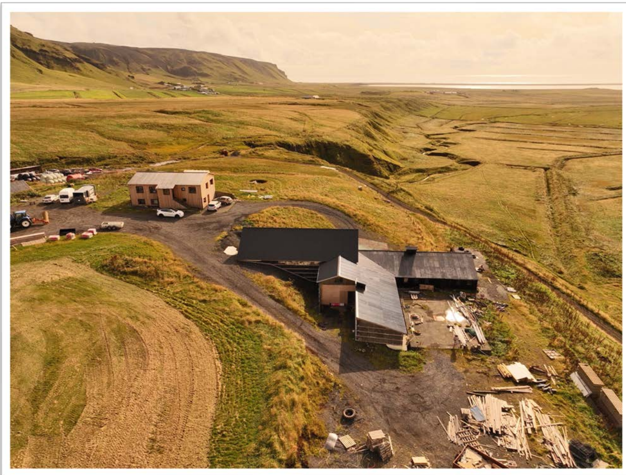
Mynd 8: Rannsóknarsvæðið að Suður-Fossi, horft til suðurs með Reynisfjall í efra vinstra horni (KM 2023)
