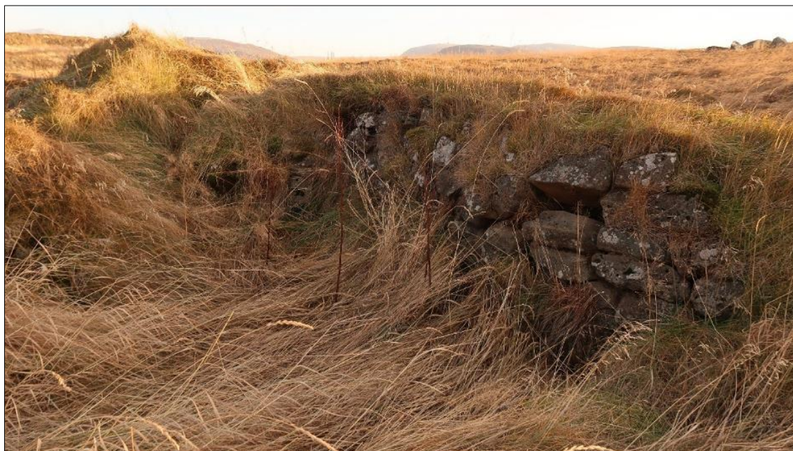
Mynd 177. Horft yfir stöndugar vegghleðslur syðsta hússins (G) til austurs að Mosfelli og Helgafelli.
