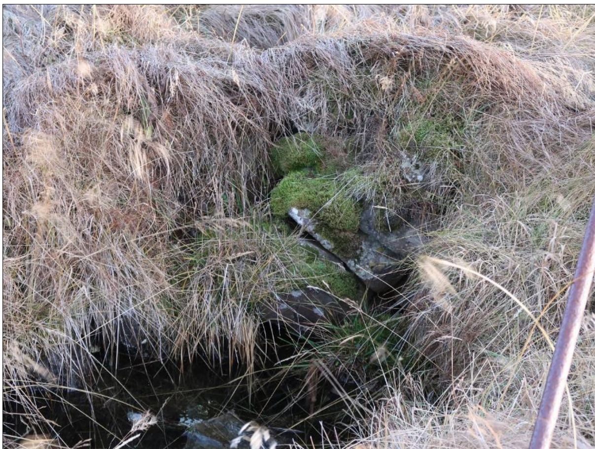
Mynd 213. Horft til austurs yfir brunn (274-14) í Glóru og grjóthleðslur í honum. Járnstöngin til hægri.
