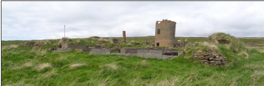
Mynd 29. Horft framan á suðurgafra fjárhúsa. Vestasta húsið er elst (t.v.) en þrjú þau eystri hafa verið endurnýjuð að hluta með steinsteypu. Aftar t.v. eru votheysgryfjur og næst þeim hlaða og súrheysturn.
