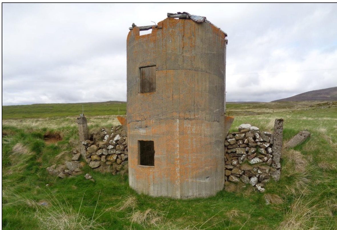
Mynd 33. Súrheysturninn, byggður inn í innanverðan norðurlangvegg hlöðunnar.
