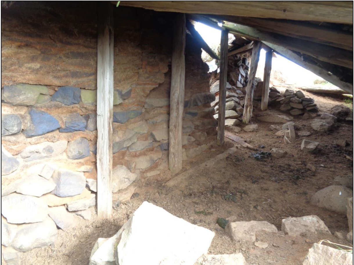
Mynd 14. Vel varðveittir hlaðnir veggir í fjósinu og stoðir standa enn.
