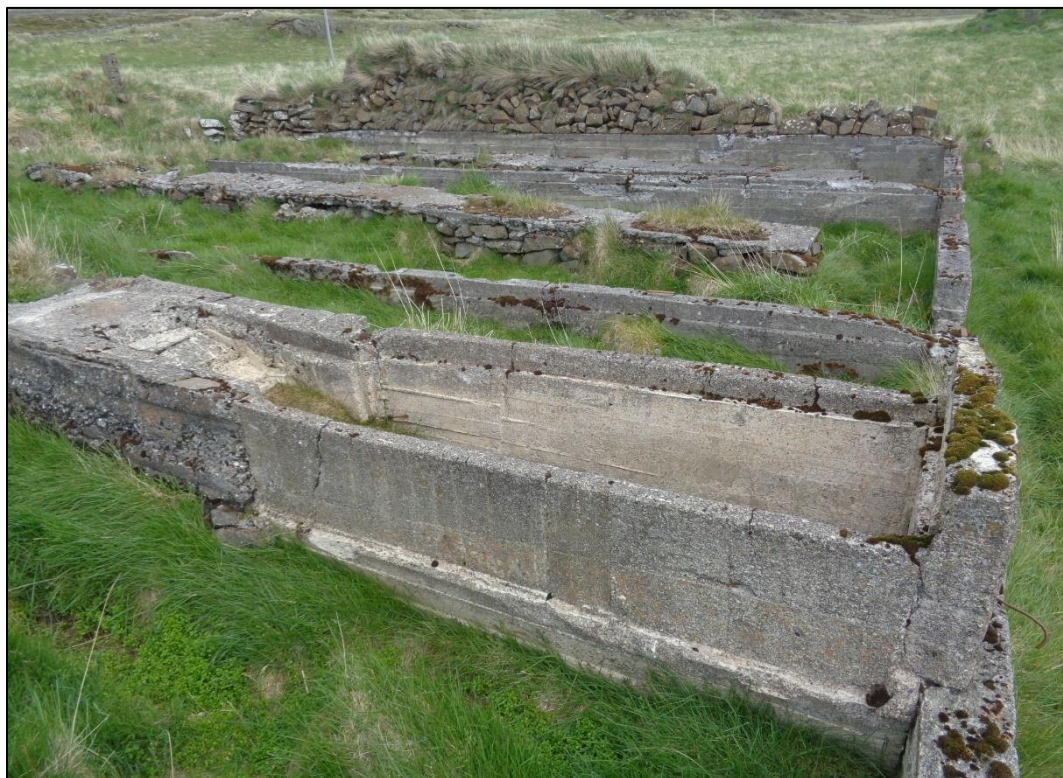
Mynd 35. Eystri fjárhúsin endurnýjuð með steinsteypu. Horft austur að hlöðnum útvegg.
