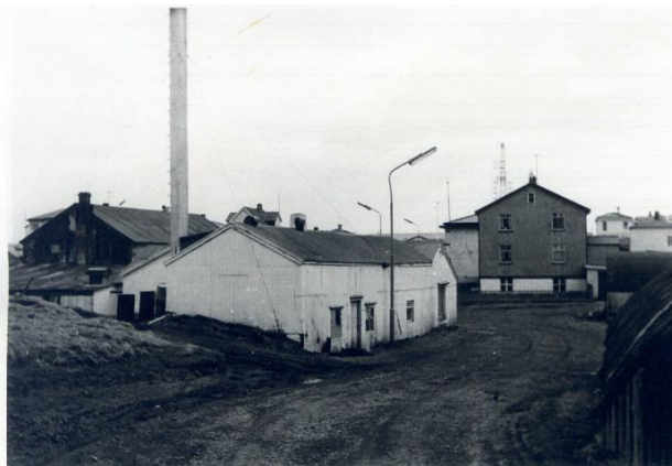
Mynd 11. Sláturhúsið við hlið Gömlubúðar. Hér.A-Skaft/ 1992-35-59.
