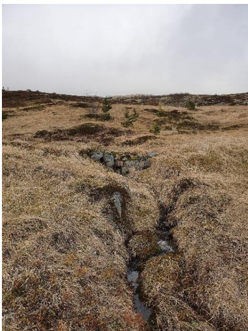
Mynd 4. Brú [2982-006] á læk ofan túns á Einarssstöðum/Grund
