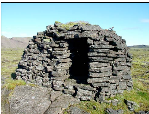
Mynd 3. Hellukofinn á Hellisheiði (Ölfus nr. 46). Hann mun vera byggður um 1830 af Þórði Erlendssyni bónda á Tannastöðum (d. 1872). Kofinn er borgghlaðinn, en þá eru hellur látnar halla líttillega út á við svo vatn megi renna út, en ekki inn. Þessi tækni var aðalega notuð við byggingu fjárborga hér á landi, en talin upprunnin á Írlandi. Kofinn var friðlýstur árið 1971. (Horft mót VNV. Ljósm. BFE.
