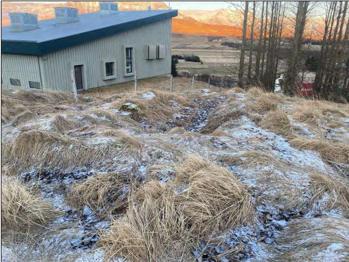
Mynd 44. Horft norður yfir fjárhús [2702]. Dælustöðvarhús sést v.m.
