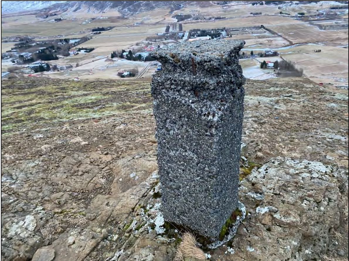
Mynd 25. Steypur stöpull [2768].
