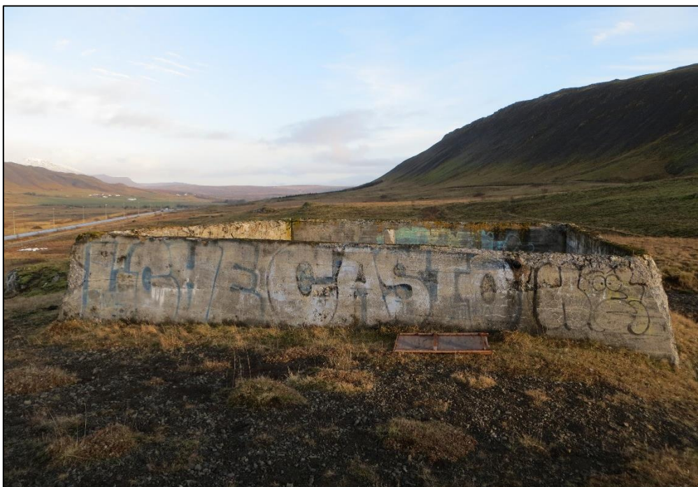
Mynd 31 Steypuþóft frá vatnsgeymi [2565].
