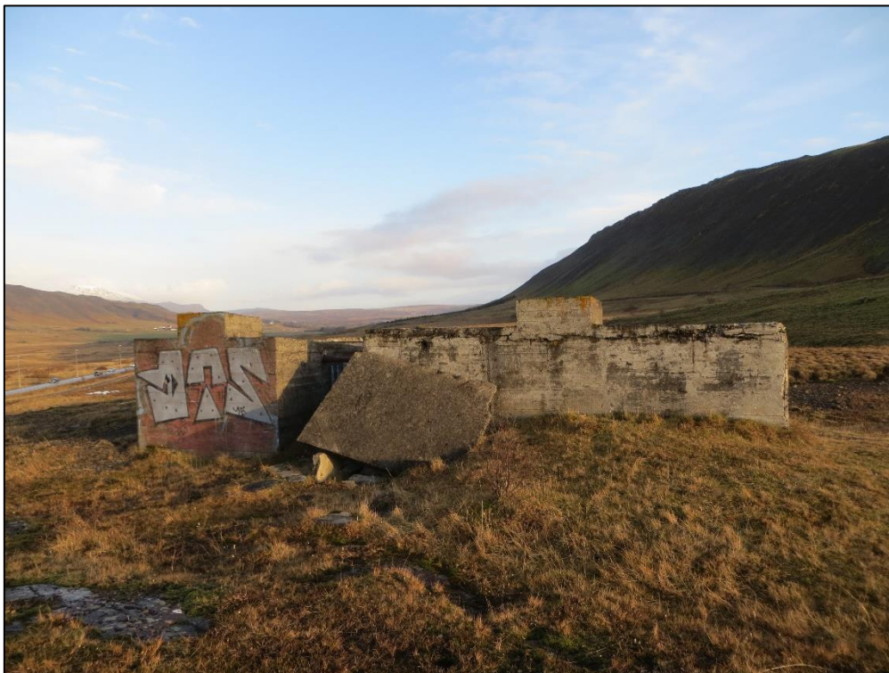
Mynd 30 Vatnsgeymir [2564], tvö steipt mannvirki tengd saman með röri.
