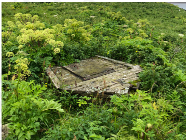
Brunnur 008, horft til suðurs.
