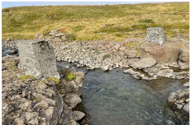
Mynd 161. Brú [2867-272], horft til NV.
