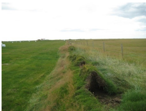
Túngarður 047, horft til suðvesturs
