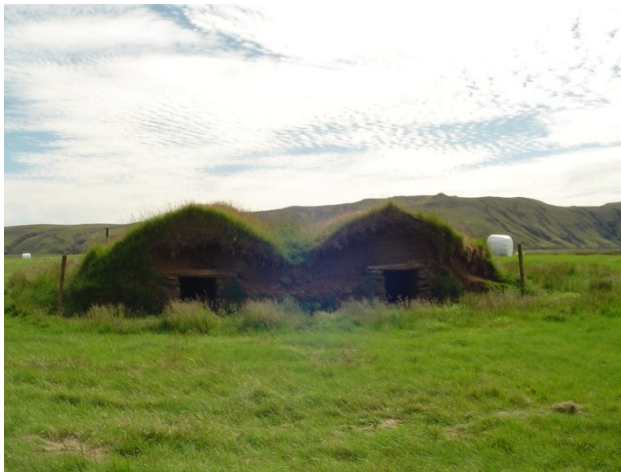
Framtúnslambhús 037, horft til suðurs
