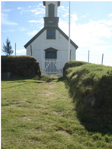
Leið 186, horft til austurs
