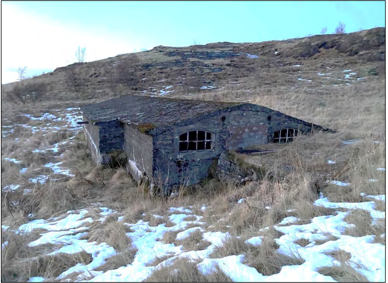
Mynd 9. Steypt steinbygging [2840-1904].
