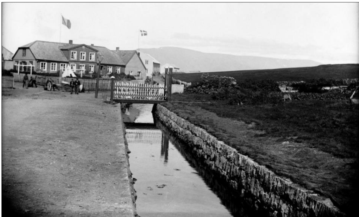
Mynd 38. Lækurinn fyrir 1894, grjótið í hleðslunni er tilhöggið og sjást þrjár steinaraðir. Brúin yfir lækinn er vönduð göngubrú yfir á lóð Landshöfðingjabústaðarins (Stjórnarráðsins). Fjær er Siemenshús, Hafnarstræti 23, en Kalkofnsvegur var austan við Lækinn. 68
