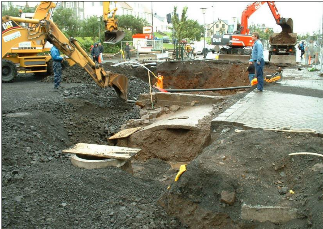
Mynd 45. Framkvæmdir við Bankastræti og Lækjargötu árið 2003. Steypta bogamannvirkið leysti steinhlöðnu brúnna (5-797) af hólmi, líklegast þegar læknum var lokað. 75
