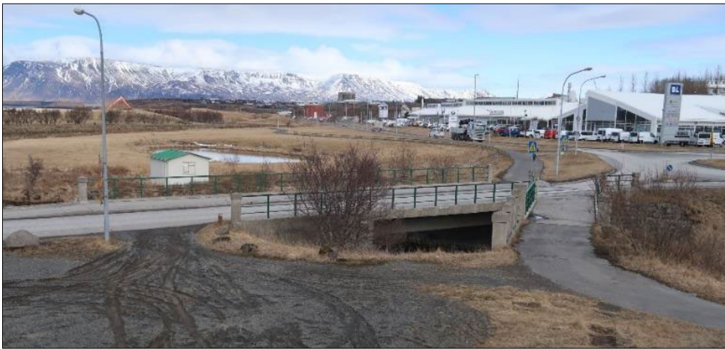
Mynd 9. Eystri Elliðaárbrúin (232-23). Til hægri er sá hluti sem er notaður sem göngubrú í grunninn frá 1883, norðar er svo nýrri brú eða frá 1940, notuð sem akvegur.
