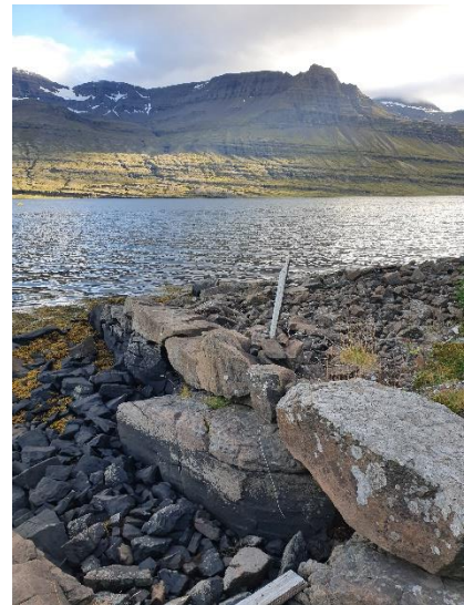
Mynd 6. Hleðslur úr austur bakka bólverksins [2813-6].
