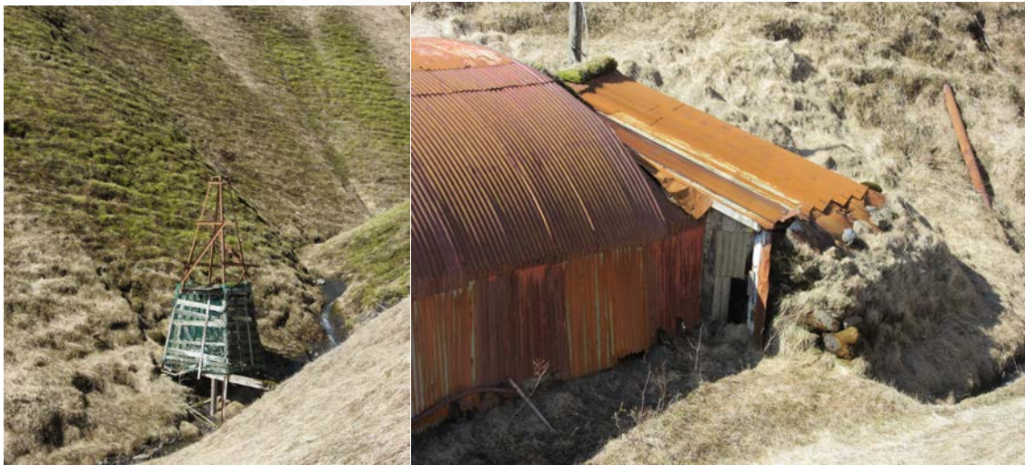
Mannvirki SF-177:028. A til vinstri, (borft til austurs) og B til hægri (borft til S.A)
