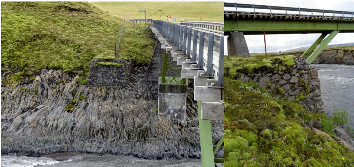
Eldra brúarstaðið yfir Eldvatnið SF-175:041. Á ljósmynd til hægri er horft til suðvesturs en til norðurs
