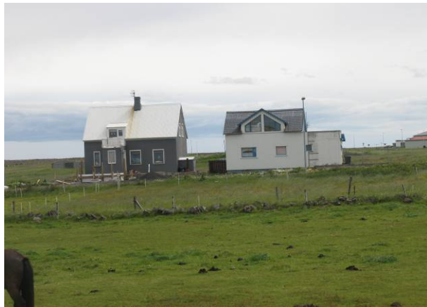
Bæjarstæðið í Kothúsum, horft til norðausturs
