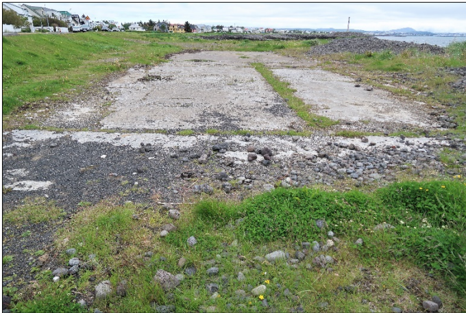
Mynd 23. Steypt plata (5-503) sem var í fiskverkunarhúsi sem byggt var 1926, horft til suðausturs.
