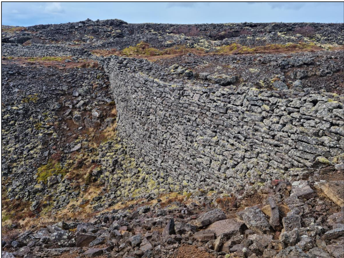
Mynd 3 - Hleðsla undir vatnsveitustokk (1780-3527) í Lambagjá
