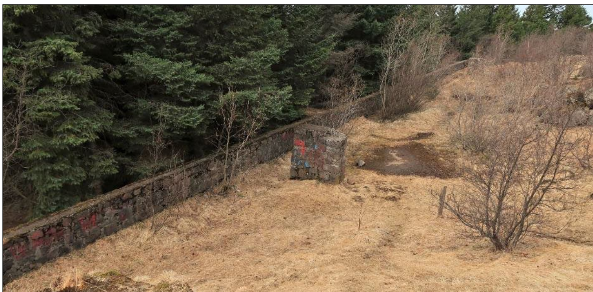
Mynd 148. Horft yfir svæðið þar sem miðjutankurinn (5-390) stóð áður. Horft til norðvesturs.
