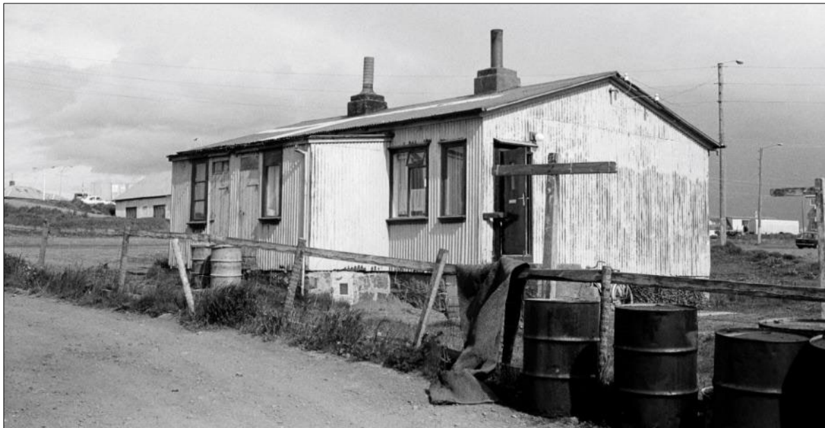
Mynd 39. Kálfakot við Vatnsmýrarveg, var hluti af Pólunum. 67
