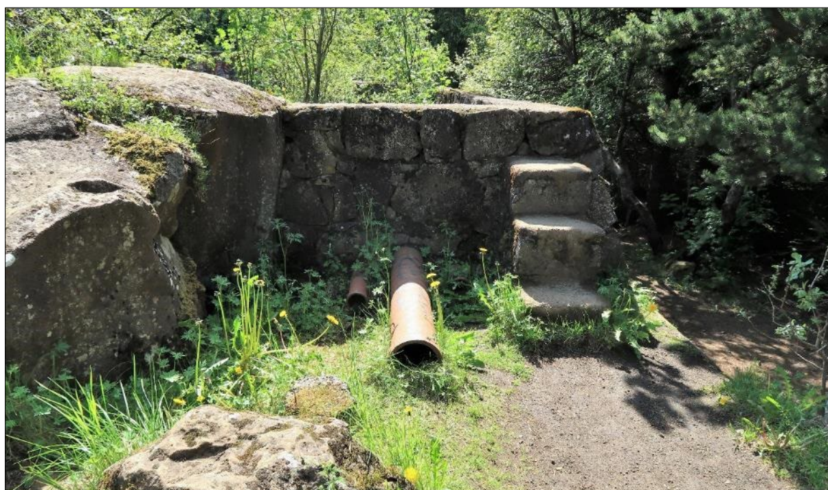
Mynd 146. Norðurendi á varnarvegg (5-172) og hluti af pípum sem hafa legið eftir veginum (5-705) að dælustöð (5-173) norðan við, sjást á ljósmynd við skráningu (5-174). Horft til suðurs.
