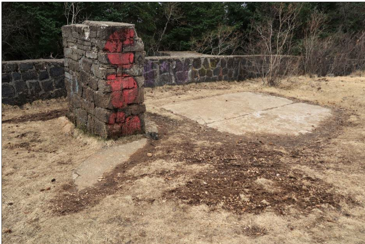
Mynd 147. Steyptur grunnur og hlaðinn stöpull þar sem nyrsti tankurinn (5-390) stóð áður. Horft til vesturs.
