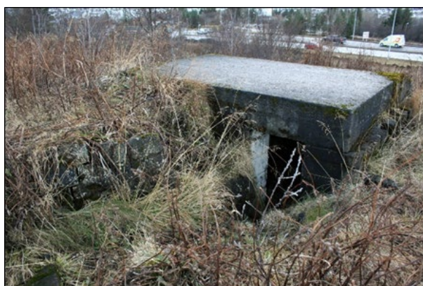
Mynd 178. Skotbyrgi (5-216), horft til suðurs að Bústaðavegi.
