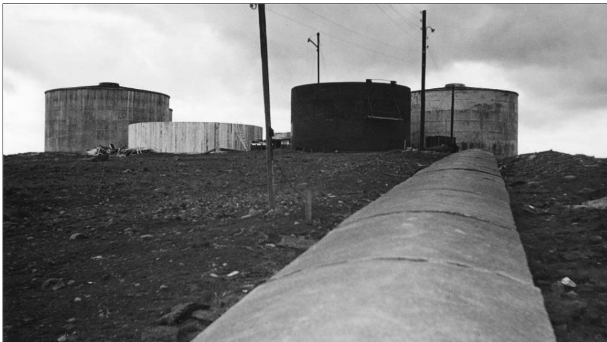
Mynd 113. Horft í vestur eftir Reykjæðinni (5-733) að eldri geymum Hitaveitunnar á Öskjuhlíð. Gömlu hitaveitustokkarnir voru með kúptu loki. 290
