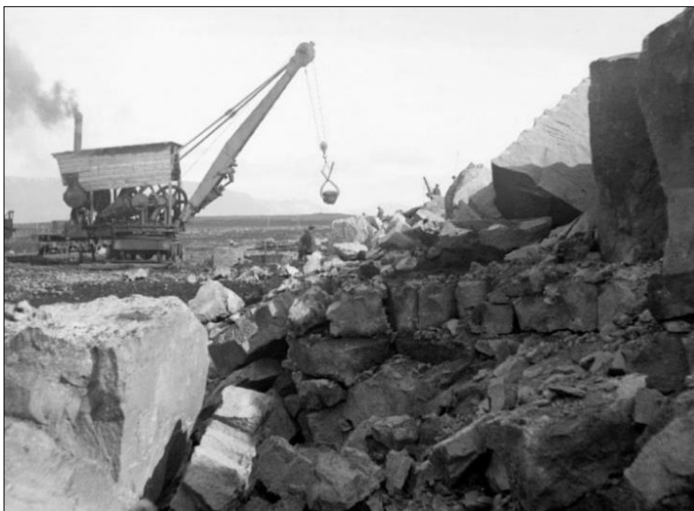
Mynd 19. Grjótnáman við Öskjuhlíð, gufuknúinn lyftikrani að störfum um 1913. Horft í norðaustur með klettastallinum. 37
