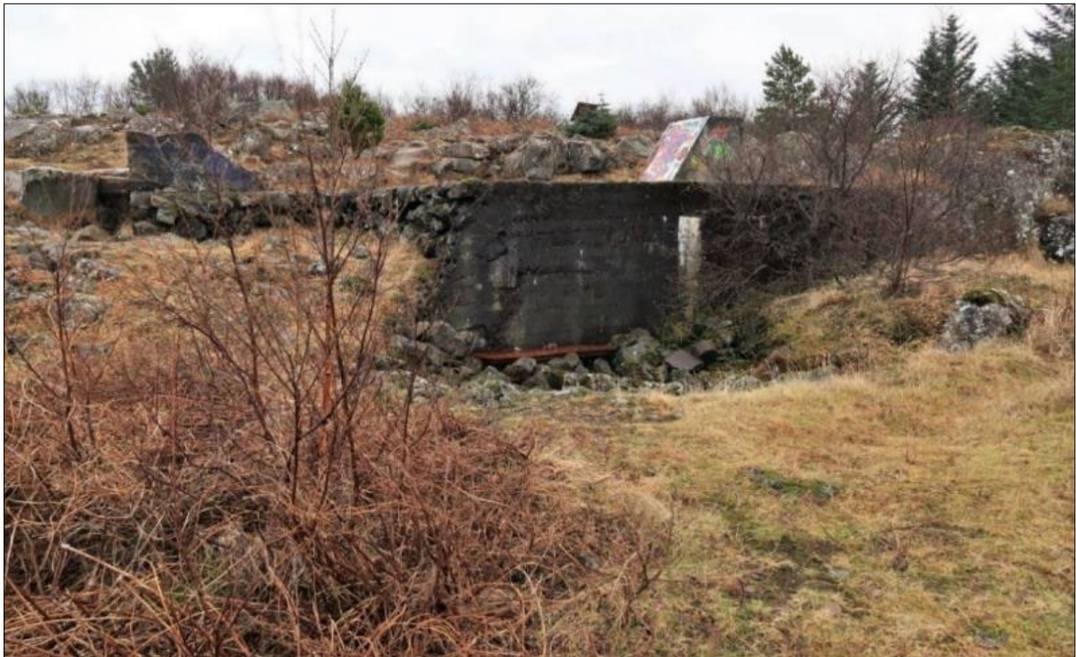
Mynd 135. Steinsteipt byrgi, stjórnstöð, (5-167). Horft til suðausturs. Fyrir framan það liggur járnhurð sem var fyrir öðrum hvorum innganginum.
