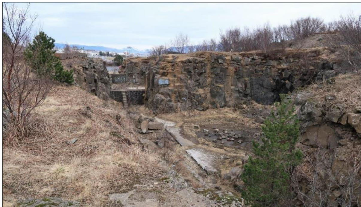
Mynd 124. Gryfjur (5-163) fyrir eldsneytisgeyma í Öskjuhlíð. Hlaðnir veggir skilja gryfjurnar að, hlaðin þrep eru beggja vegna við vegginn. Horft til norðurs.
