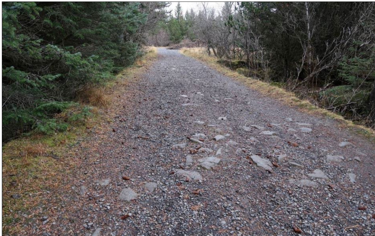
Mynd 241. Púkk í upphlöðnum vegi að sprengjugeymslunum (5-718) vestast, horft til norðausturs.
