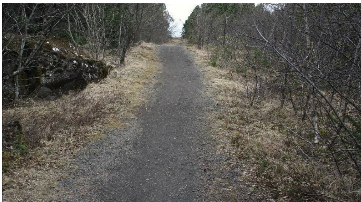
Mynd 91. Vegur (5-243), horft til austurs.
