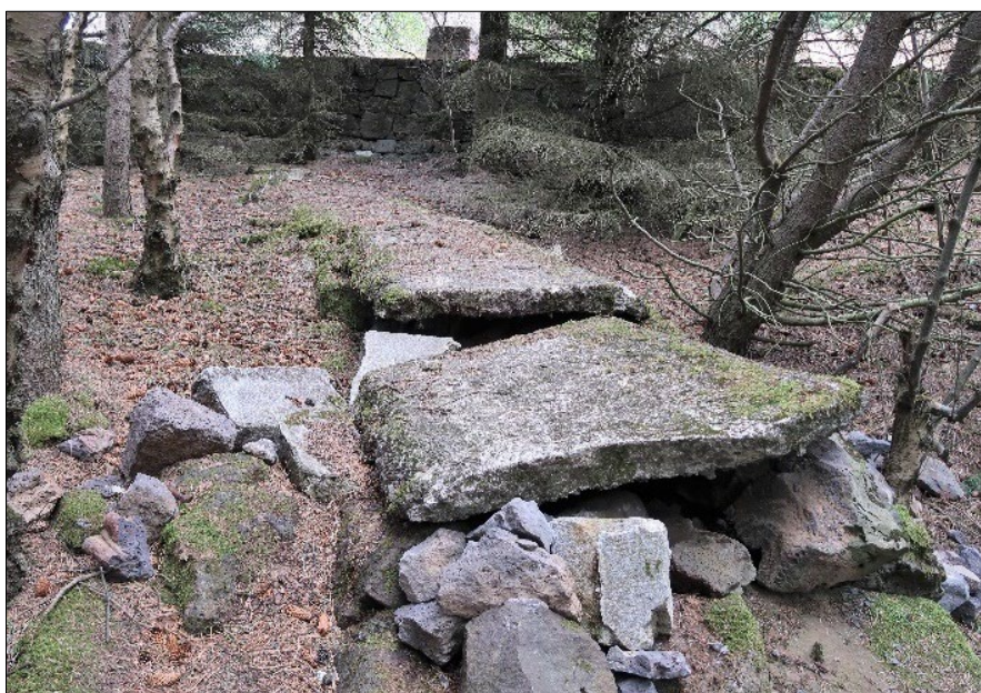
Mynd 250. Stokkur (5-740), horft til norðausturs að varnarveggnum (5-172).
