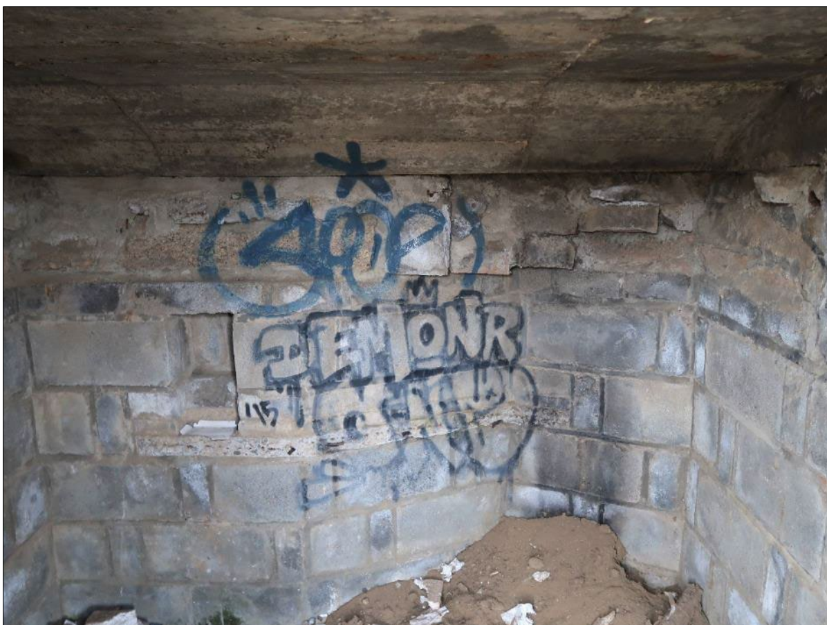
Mynd 266. Horft inn í skotbyrgi (5-760) til suðvesturs. Búið er að fylla upp í skotraufina. Efst má sjá hallann á steypu þakinu.
