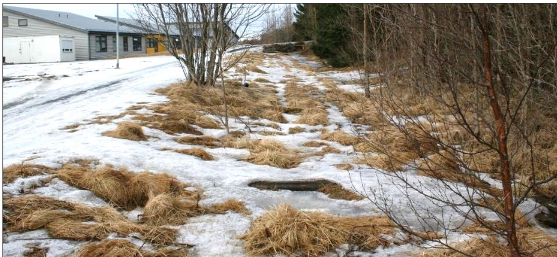
Mynd 197. Undirstaða (5-532), horft til norðurs.
