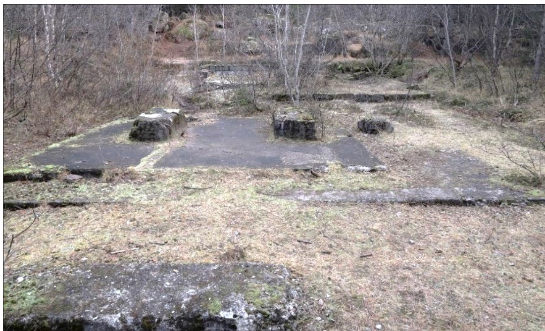
Mynd 151. Dælustöð (5-173), horft til austurs að vegi (5-705) sem er austan við.
