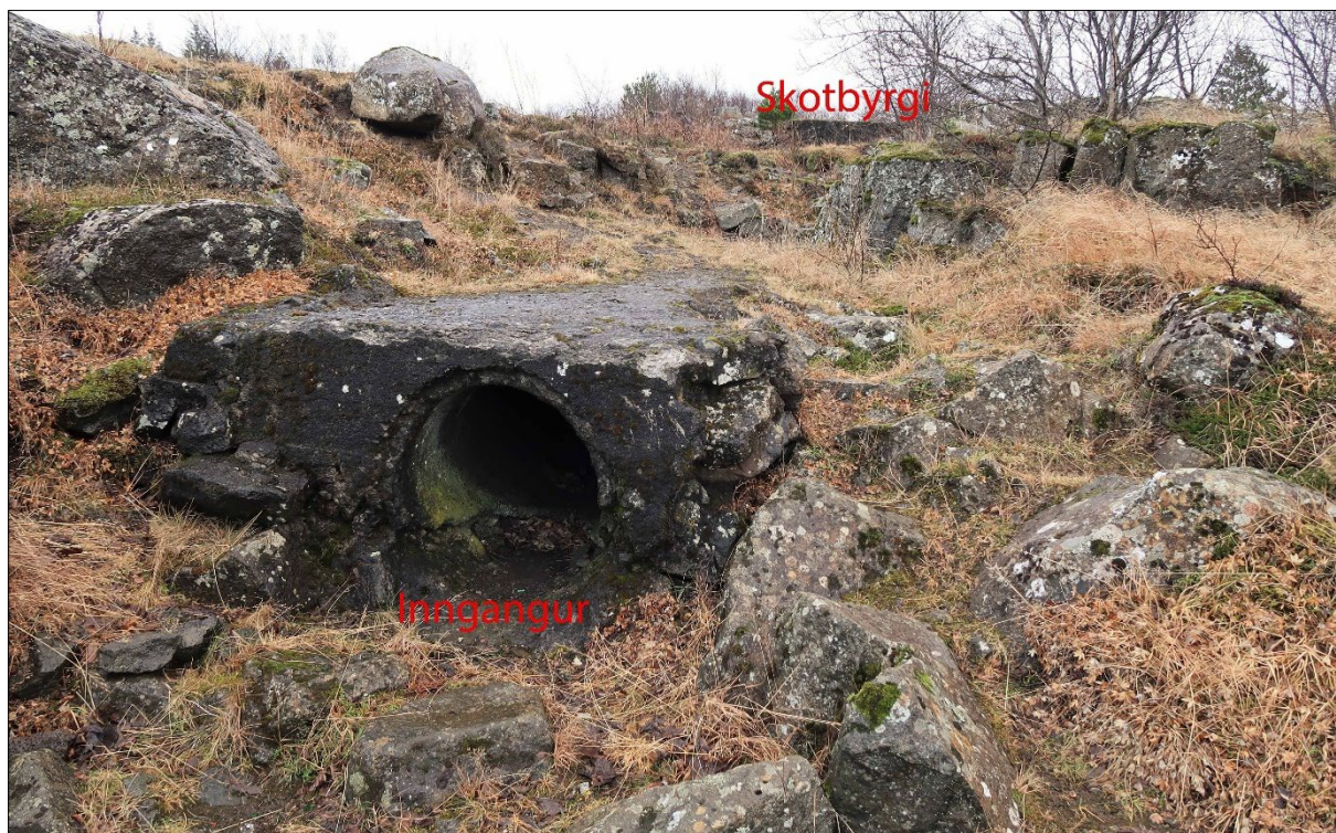
Mynd 138. Þriðji inngangurinn í byrgið (5-167) er niðurgrafið steyptrör sem liggur frá suðurhlið byrgisins 23 m til norðvesturs. Horft til suðausturs upp að byrginu sem er við furutré ofarlega fyrir miðri mynd.
