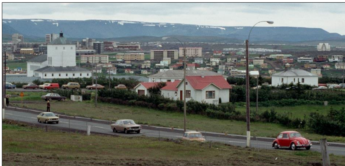
Mynd 90. Býlið Sólland við Reykjanesbraut. 199
