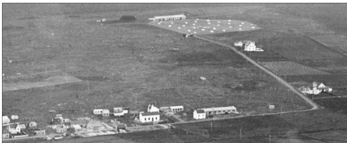
Mynd 48. Byggðin við Rauðarárstíg og Háteigsveg um 1928. Efst á myndinni eru Vatnsgeymarnir (5-513), fiskverkunarhús Ara Fróða (5-670) og stakkstæðið (5-673), neðar við Háteigsveg er Háteigur og Sunnuhvoll. 100
