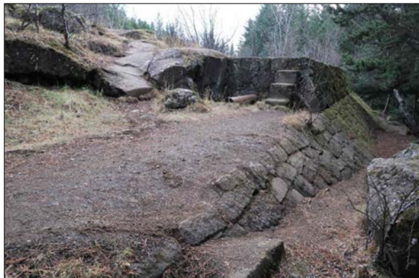
Mynd 217. Vegur (5-705) við varnarvegginn (5-172) og pípana, horft til suðausturs.
