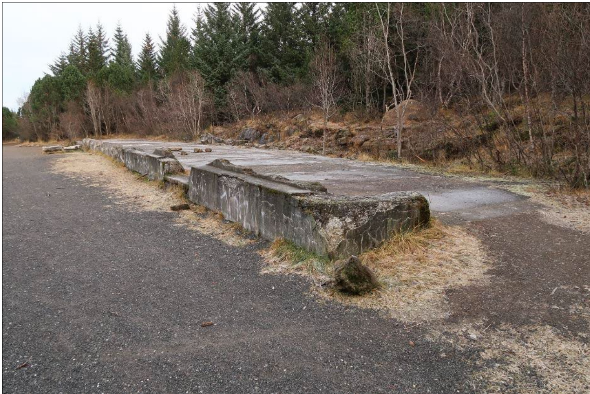
Mynd 154. Grunnur vararafstöðvar (5-174), horft til norðnorðvesturs.
