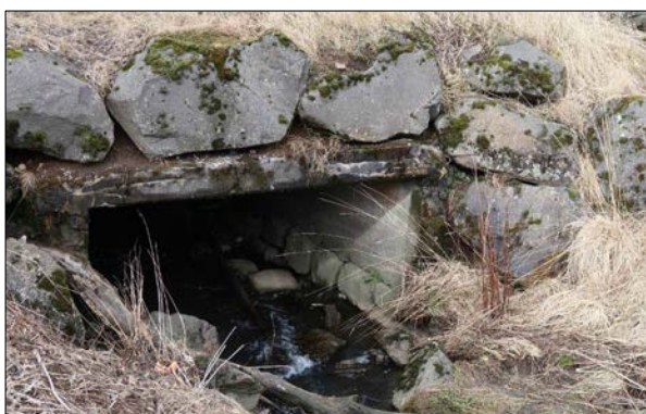
Mynd 88. Horft til norðvesturs undir brúna á grjóthleðslur og steinsteypu í stöplum og gólfi.
