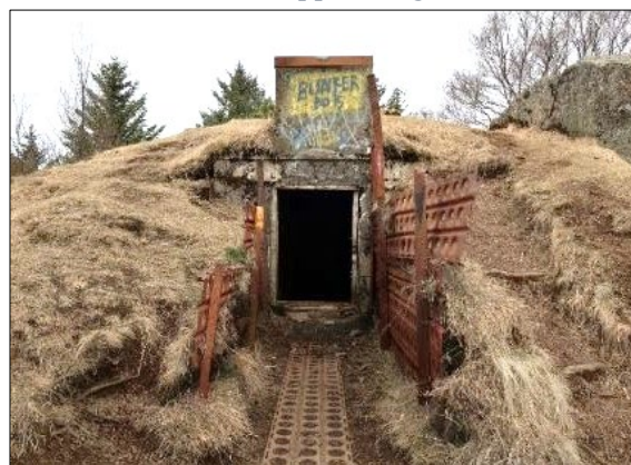
Mynd 145. Vatnsgeymir (5-170). Horft til norðurs að dyrum á suðurgafli.
