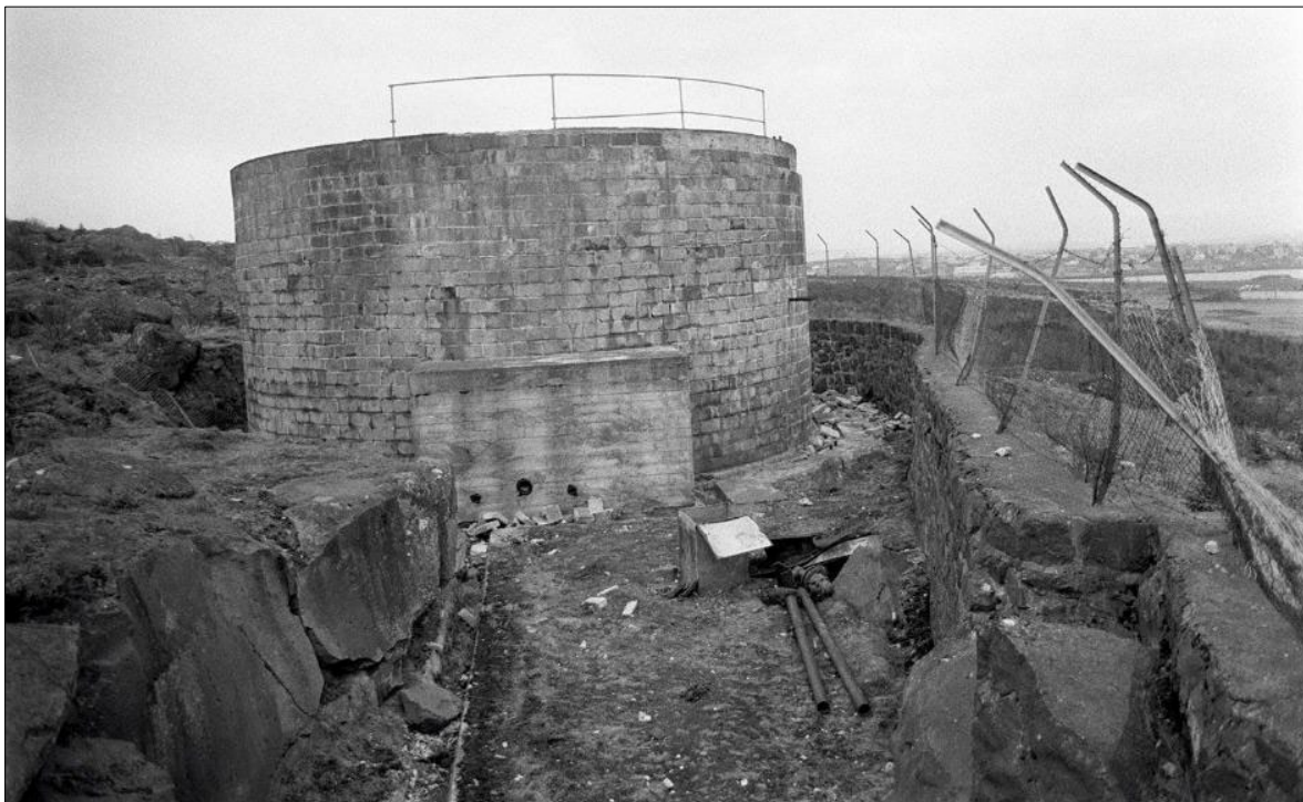
Mynd 187. Syðsti eldsneytistankurinn (5-390) árið 1977. Horft til suðausturs. Sjá má leiðslur og lokabúnað. Búið er að rífa hann og taka allan búnað. 361
