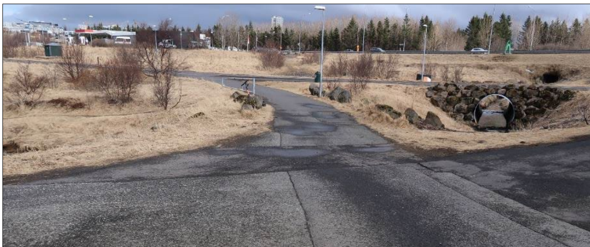
Mynd 87. Horft til norðaustur að Borgarspítalanum yfir gömlu brúna (230-186) yfir Fossvogslæk sem nú hefur verið malbikað yfir. Til hægri er ræsi undir gangstíg og fjær er Kringlumýrarbraut.
