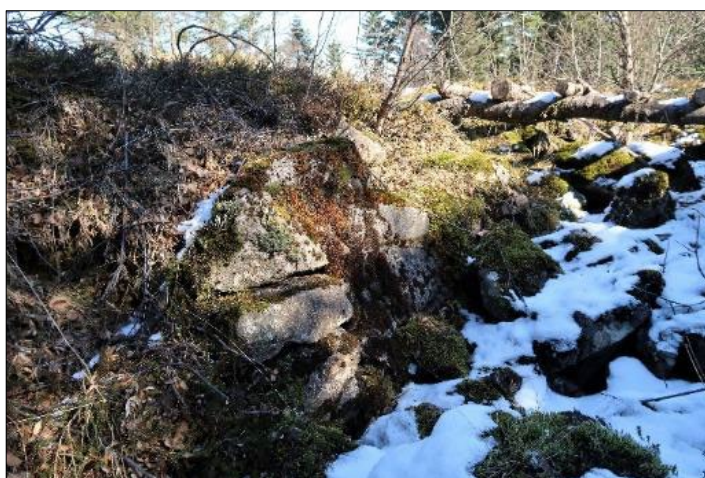
Mynd 244. Hleðslur með steypu á milli vestan megin í norðurhlíð skotgrafarinnar (5-734). Horft til norðurs.
