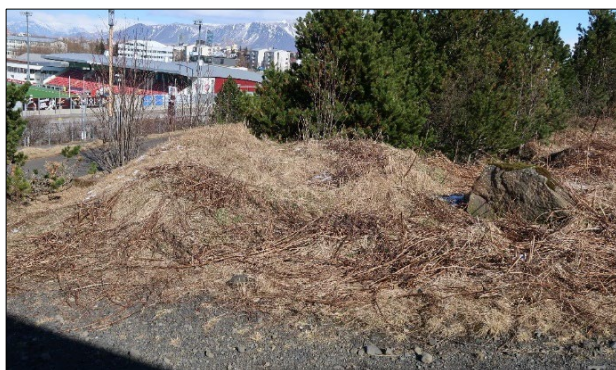
Mynd 184. Sprengiskýli (5-244). Þakið fallið niður. Horft til norðurs.
