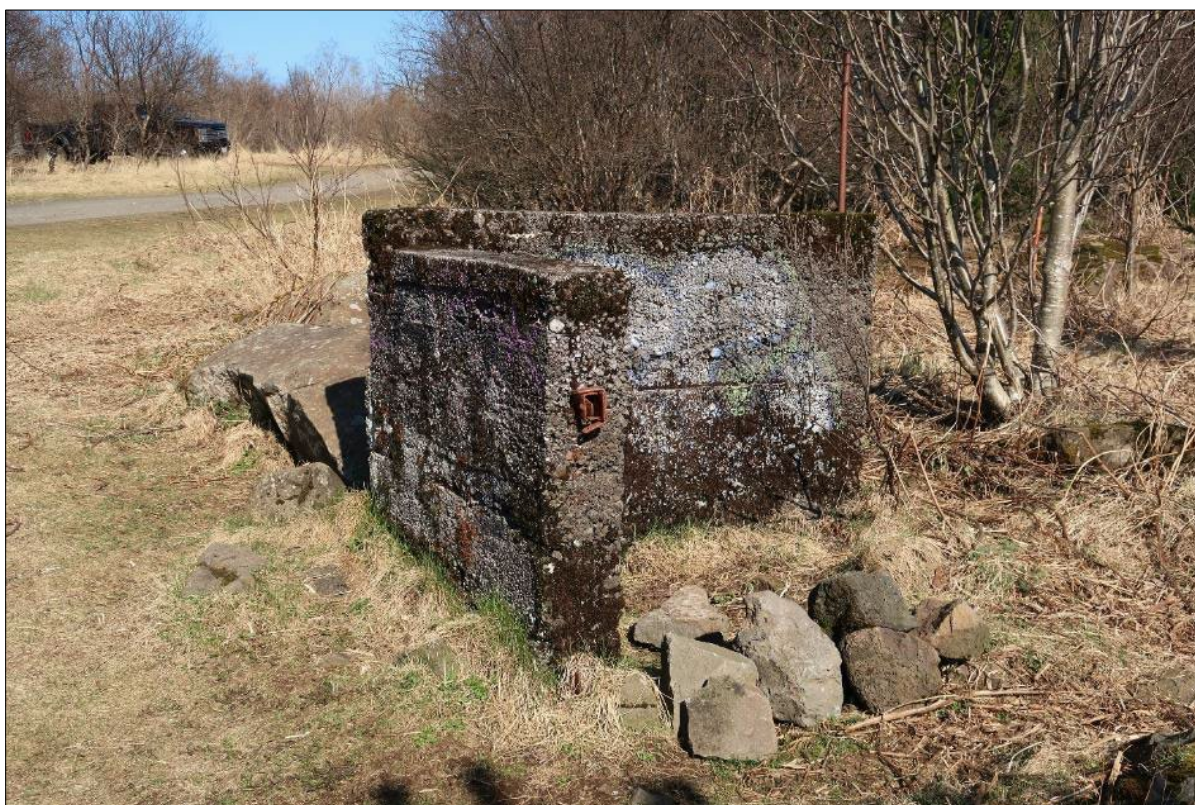
Mynd 112. Steinsteypt girðingarhorn (5-724) á norðvesturmörkum á Leynimýrarbletti 4. Horft til norðurs.
