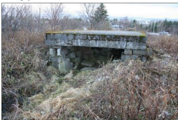
Mynd 182. Skotbyrgi (5-217), horft til suðurs að Bústaðavegi.
