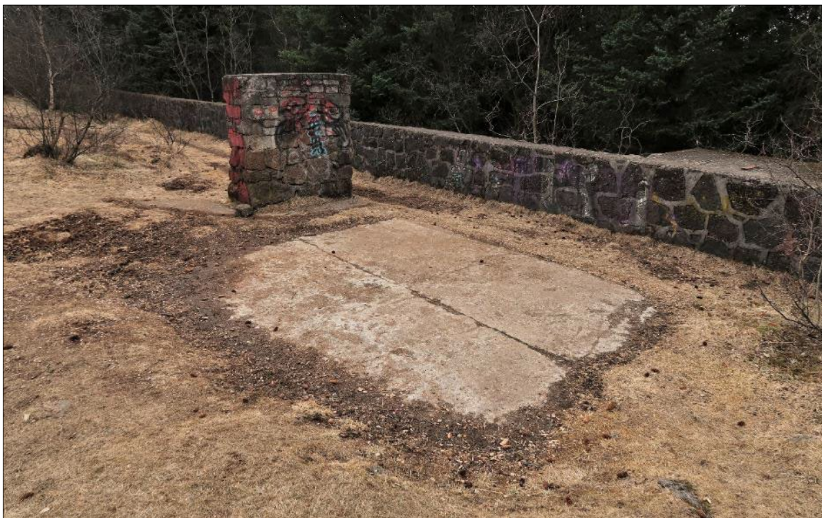
Mynd 190. Steyptur flötur og hlaðinn stöpull þar sem nyrsti eldsneytistankurinn stóð (5-390). Horft til suðurs.
