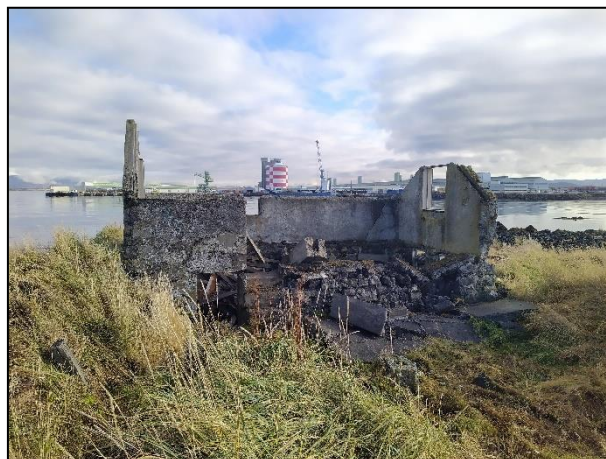
Mynd 8 - Íbúðarhúsið við Þýskubúð (2367-122). Húsið er hrunið að hluta og kjallarinn fullur af efni.
