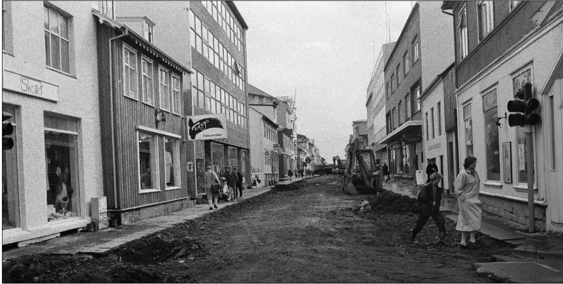
Mynd 10. Laugavegur, horft í austur frá Klapparstíg, vinstra megin er Klapparstígur 31, Laugavegur 23, 25 og 27, til hægri Laugavegur 22, 22A, 24, 26. Framkvæmdir á svæðinu, skipt er um jarðveg í götukassa. 17
