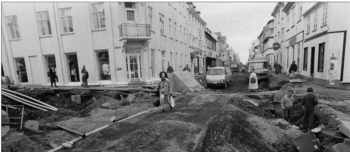
Mynd 11. Laugavegur, horft í vestur frá Frakkastíg. Til vinstri er Laugavegur 42, 40A, og 40, til hægri er hús sem nú er Frakkastígur 8, svo kemur Laugavegur 45, 43 (Vínberíð) og 41. 18
