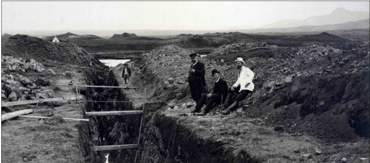
Mynd 37. Lagning vatnsveitunnar 1908 eða 1909. Yfirverkfræðingur framkvæmdanna, H. A. Hansen, stendur við skurðinn, en við hlið hans situr Knud Zimsen, þáverandi bæjarverkfræðingur Reykjavíkur. Í baksýn sjást Rauðhólar og Vífilsfell. 84
