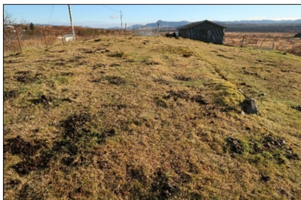
Mynd 73. Steinsteyptur húsgrunnur norðvestan við hesthús, horft til suðausturs.
