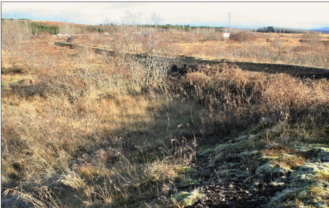
Mynd 58. Brúarstæðið (213-70) við Rauðhóla, á gamla veginum (213-76). Þar er nú ræsi úr járni. Horft til austurs.
