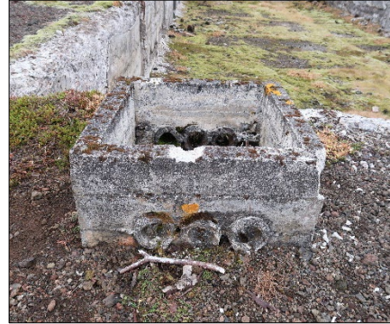
Mynd 46. Steypur kassi við norðurgafli (214-102), horft til suðurs.
