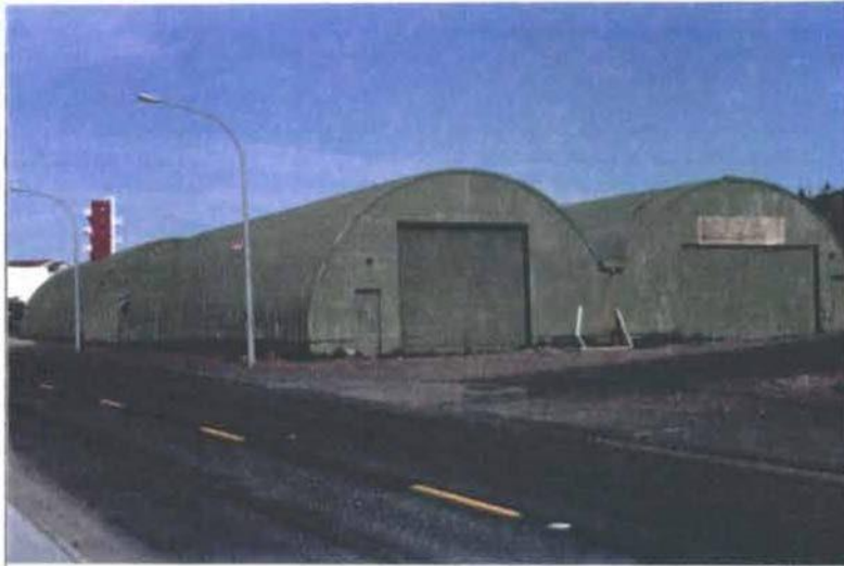
Minjar 31: Birgðaskemmur við Flugvallarveg. Þær hafa verið klæddar upp eftir stríðið. Varðveisluflokkur: B.
