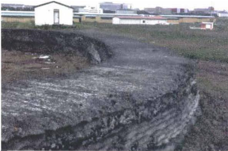
Minjar 71: Flugvélabyrgi, það stærsta á Reykjavíkurflugvelli. Það var gert úr sandpokum og steypu sturtað á milli. Nú eru sandpokarnir horfnir. Bandaríkjamenn voru með byrgið og geymdu í því Douglas-flugvél lengi. Hún var mikið notuð til fallhlífaæfinga. Fjöldi annarra flugvélabyrgja var á vellinum, gerð úr sandpokum, mold og grjóti.
