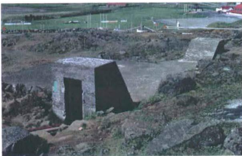
Minjar 21: Neyðarstjórnstöð yfirstjórnar flugvallarins ef til stórfelldrar árásar kæmi. Þarna eru nokkur herbergi neðanjarðar og tveir aðalútgangar. Járnhurð liggur fyrir framan annan útganginn. Grjót var ofan á þakinu á sínum túna og mætti setja aftur í einhverjum mæli. Varðveisluflokkur: A.
