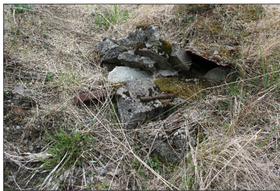
Mynd 22. Við innganginn er grjót, steypa og járn.
