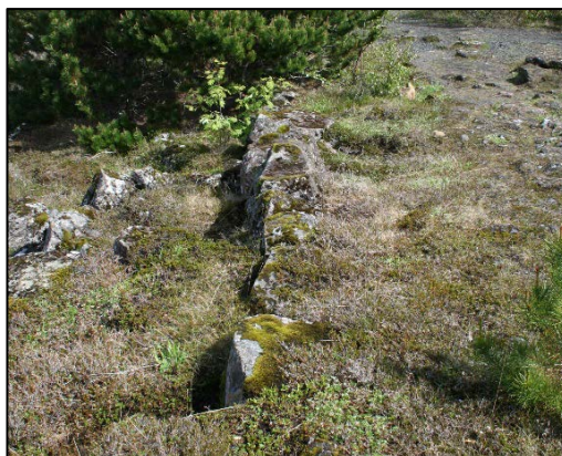
Mynd 20. Einföld grjóthleðsla í norðurkanti á vegi.
