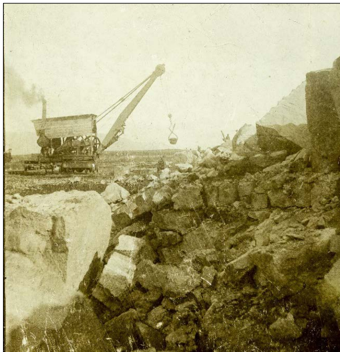
Mynd 3. Hér má sjá gufukrana lyfta upp grjóti í Öskjuhlíðinni um 1913. 8
