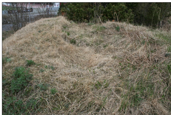
Mynd 21. Jarðhýsi (5-244). Þakið fallið niður.
