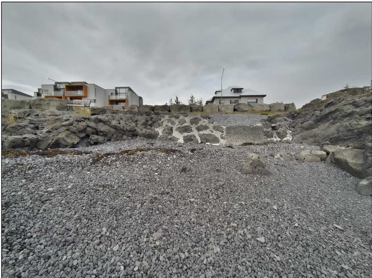
Mynd 16 - Hafnarmannvirki lifrabræðslustöðvarinnar að Gönguhóli (2307-105). Gísli Sigurðsson nefnir þetta mannvirki „Grútarbryggju“ í Örnefnaskrá.
