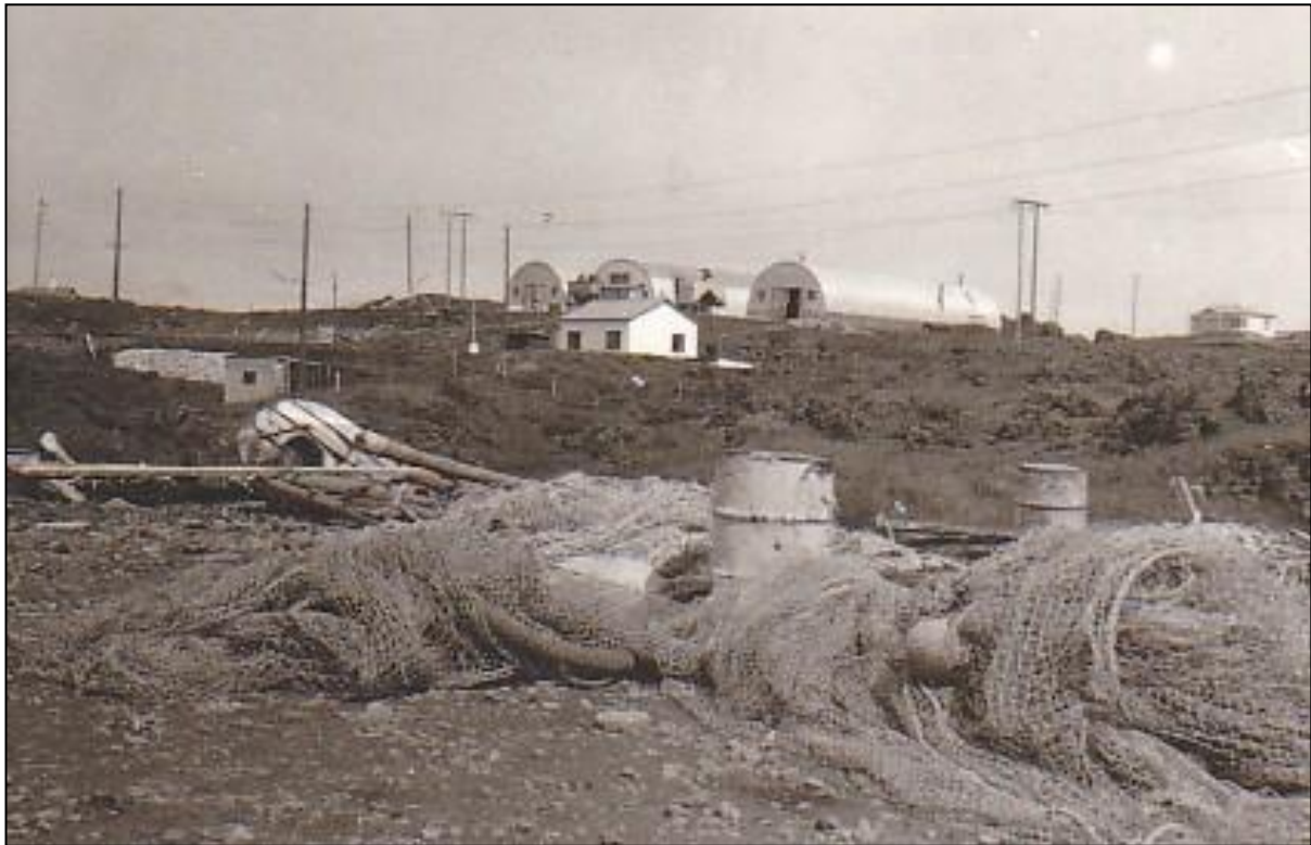
Mynd 8 - Ljósmynd frá 1974. Horft upp að bröggum (2307-61, 2307-62 og 2307-63) og húsi (2307-134). Mynd í eigu Byggðasafns Hafnarfjarðar.
