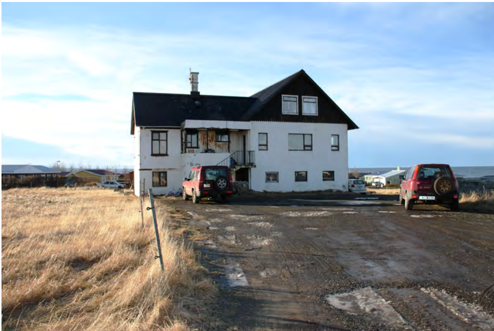
Mynd 3 Sveinskot og bæjarhlaðið
