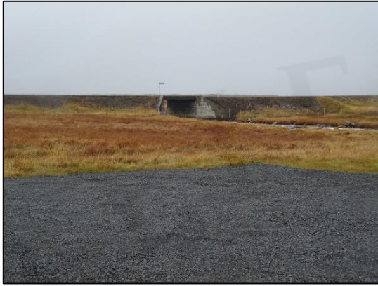
Mynd 16. Brúin yfir Helluvað 056:015, horft til VNV
