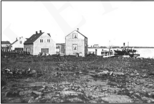
Mynd 33. Bjærkevigshúsið er til vinstri. Það var flutt í burtu árið 1940 (Heimild: Sléttunga III, bls. 56)
