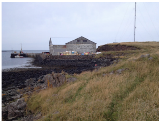
Mynd 133: Hleðsla 229, horft til V.
