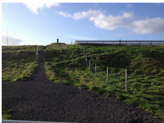
Mynd 127: Þúst 218, horft til S.
