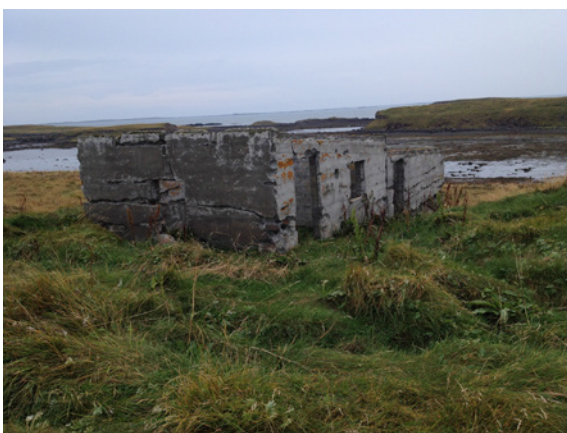
Mynd 95: Ból 152, horft til SSA.
