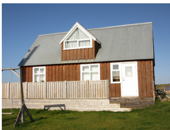
Mynd 6: Bakkabær 008, horft til NA.
