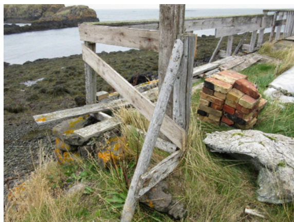
Mynd 57: Hleðsla 090, horft til NNA.
