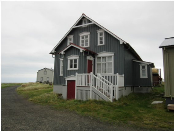
Mynd 116: Vorsalir 199, horft til NA.
