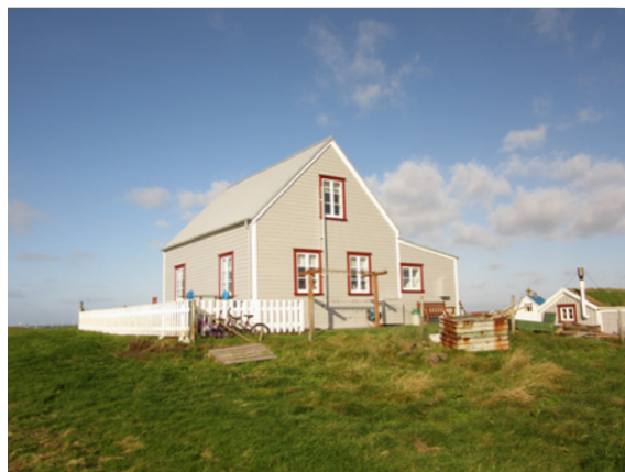
Mynd 12: Brekkubær 015, horft til S.
