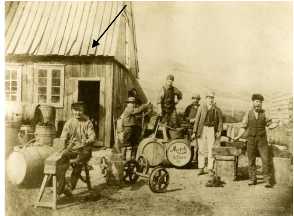
Mynd 23. Þessi mynd er tekin árið 1895 og standa mennirnir framan við hús sem er greinilega komið til ára sinna og er pakkhús. Líklega er þetta pakkhúsið sem var komið árið 1742. Ljós. Þj. Ljós. Lpr-B-1988-77.
