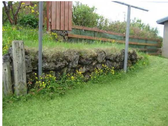
Mynd 172. Leifar af vegg útihúsana. Ljósmynd GV.
