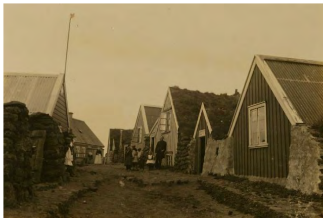
Mynd 108. Gömlu Skúmsstaðabæirnir. Ljós. Bygg Árn
