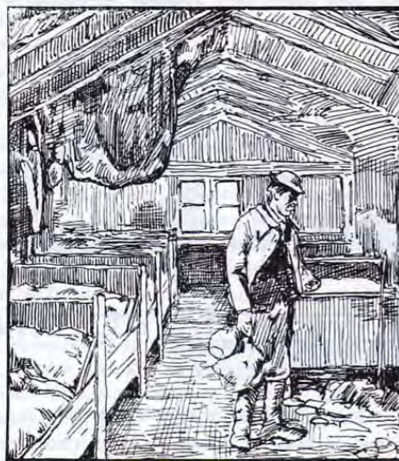
Det Indre af Søboden paa Ørebakke. (Rum A).
