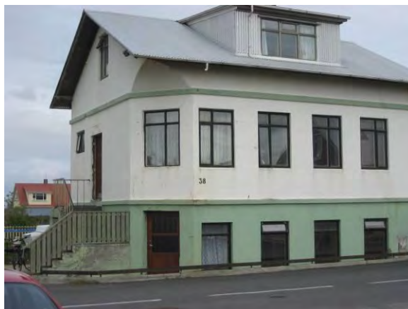
Mynd 219. Húsið Skjaldbreið. Ljósms.GV.
