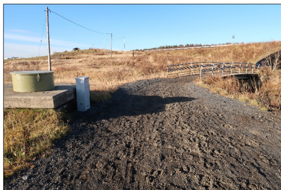
Mynd 143. Vegur (213-77), horft til norðurs.
