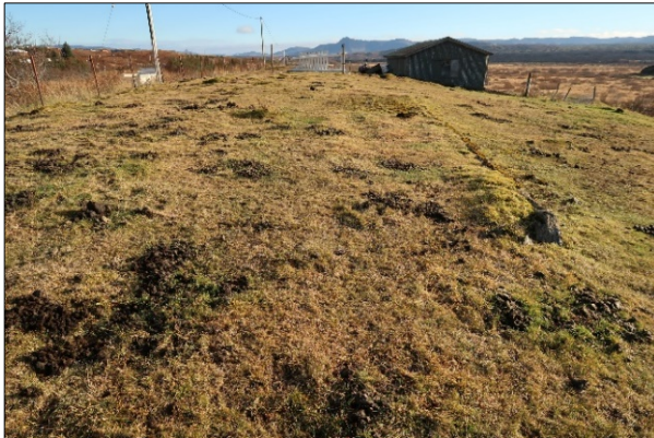
Mynd 59. Steinsteypdur húsgrunnur norðvestan við hesthús, horft til suðausturs.
