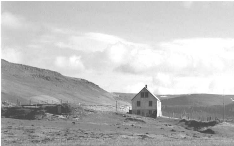
Mynd 19: Hluti úr ljósmynd Þorsteins Jósefssonar frá 1939 sem sýnir torfkofann neðan við matjurtagarðinn vinstra megin á myndinni. Fyrir miðri mynd er gamla íbúðarhúsið (nr. 2089-5) og hægra megin sér í kirkjugarðinn (nr. 2089-2). (Ljósm. Sarpur.is: ljósmynd nr. ÞJ_Barð-338)
