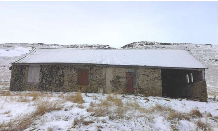
Mynd 21: Hlaðinn og steinlímdur kjallari gamla íbúðarhússins séð mót norðvestur. Vinstri helmigurinn er kjallari upphaflega hússins. Hægra helmigurinn er yngri, en byggt hefur verið við húsið í tvö skipti. (Ljós. ÓLA)
