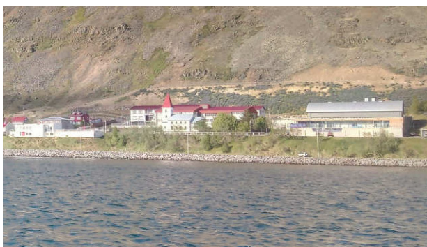
Mynd 10: Þrengt hefur verið að Eyrakirkju á Patreksfirði (reist á árunum 1904-7) að austan verðu með byggingu íþróttamiðstöðvar. Ljós. ÓLA
