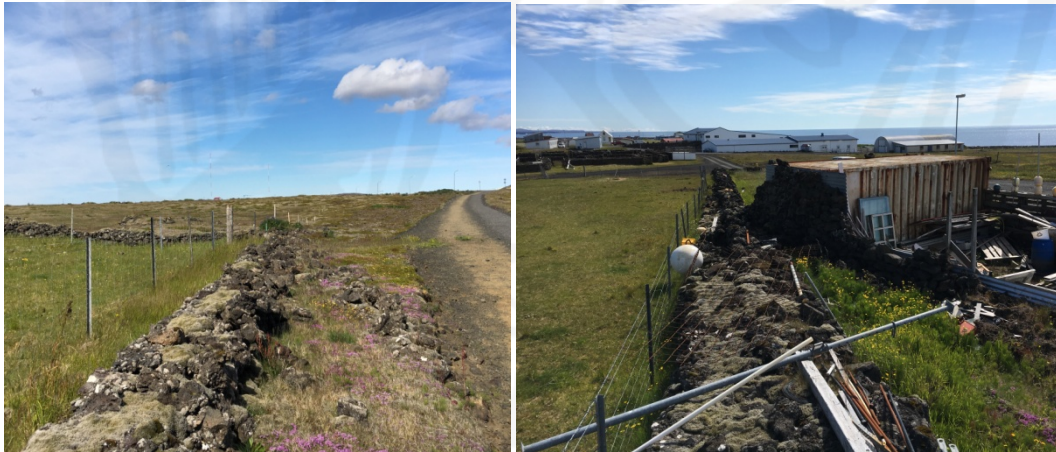
Garðlag umhverfis Auðsholt GK-011:114. Mynd til vinstri er af NA horni garðs en mynd til hægri af þvergarði sem skiptir svæðinu í tvennt
