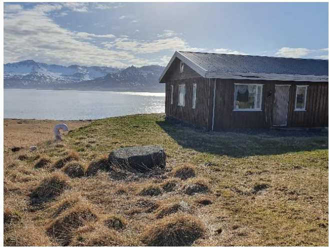
Mynd 10. Börðusteinn skammt frá NA húshorni.
