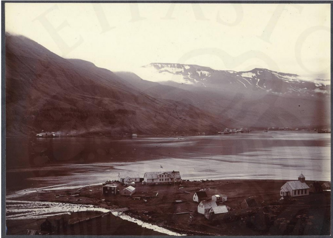
Vestdalseyri 1895. Á myndinni má sjá Gránufélagshúsið (NM-252:040) nýbyggt, fyrir miðri mynd, pakkhús hægra megin við það (NM-252:042) og Glæðheima (NM-252:034) ofar og utar. Kirkjan (NM-252:002) er lengst til hægri á mynd en nær Vestdalsá eru nokkur af íbúðarhúsunum í þorpínu, Kirkjuholshúsin, Guðnahús, Jónshús í byggingu o.fl. Myndin birtist áður í Ísland Howells, bls. 157.
