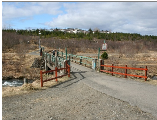
Mynd 188 Vatnsveitubruin (218-38), horft til austurs.
