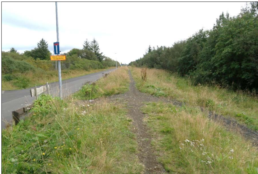
Mynd 137 Horft í austur eftir þrýstivatnspípunni (263-31) og Rafstöðvarvegi.
