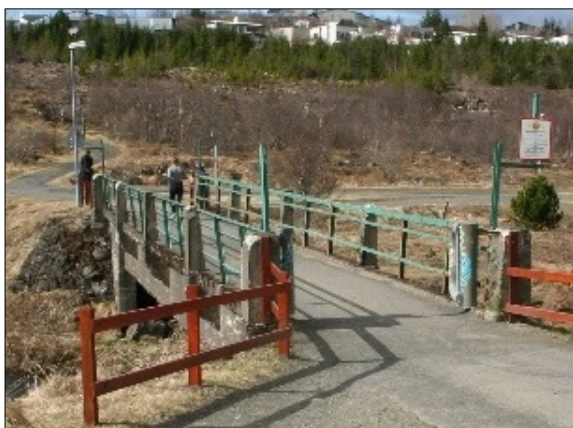
Mynd 16 Vatnsveitubríuin (218-38), horft til austurs.
