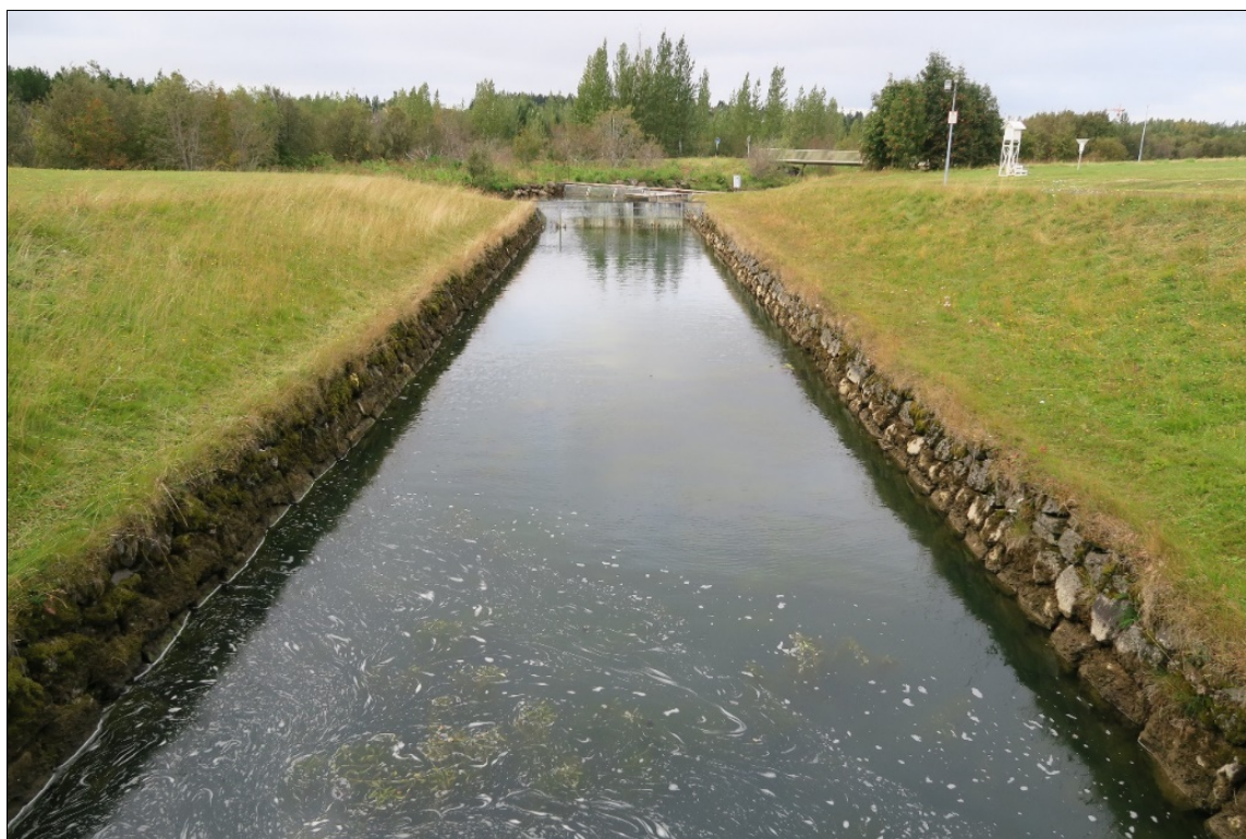
Mynd 141 Grjóthlaðnir varnarveggir með frárennslisskurði Elliðaárstöðvarinnar, horft í vestur.
