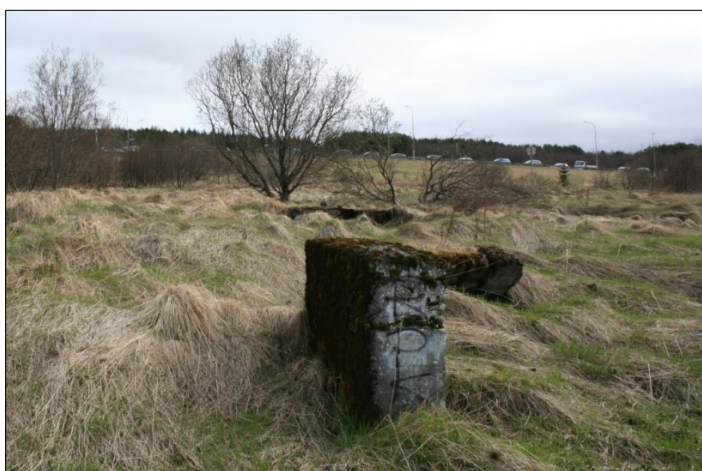
Mynd 213 Steypuleifar á lóðinni þar sem húsið Foss stóð. Horft í suður að Stekkjarbakka.
