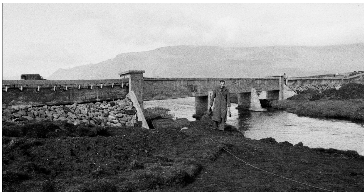
Mynd 76 Horft í norðaustur eftir Reykjaæðinni (232-62) árið 1942. Gömlu hitaveitustokkarnir voru með bogapaki. 183
