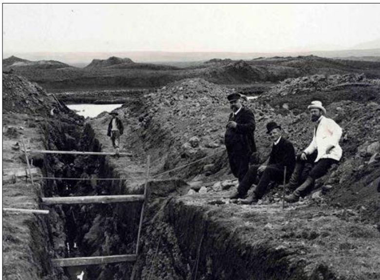
Mynd 189 Lagning vatnsveitunnar 1908 eða 1909. Yfirverkfræðingur framkvæmdanna, H.A. Hansen, stendur við skurðinn, en við hlið hans situr Knud Zimsen, þáverandi bæjarverkfræðingur Reykjavíkur. Í baksýn sjást Rauðhólar. 318
