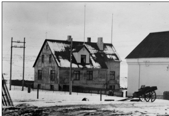
Mynd 25 Íbúðarhús rafstöðvarstjóra (norðurhlið) árið 1921. 88
