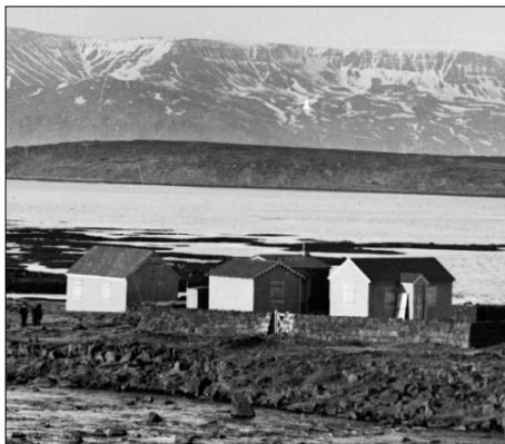
Mynd 20 Veiðihúsin hin neðri við Elliðaárósa á árunum 1905-1920. 77
