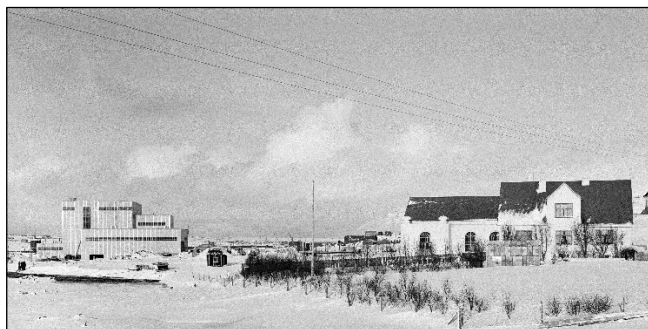
Mynd 29 Toppstöðin í byggingu (til vinstri), rafstöðvarhúsið og íbúðarhús rafstöðvarstjóra (til hægri) árið 1948. 93
