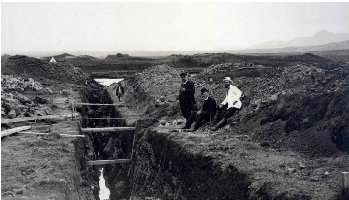
Mynd 15 Lagning vatnsveitunnar 1908 eða 1909. Yfirverkfræðingur framkvæmdanna, H. A. Hansen, stendur við skurðinn, en við hlið hans situr Knud Zimsen, þáverandi bæjarverkfræðingur Reykjavíkur. Í baksýn sjást Rauðhólar. 72
