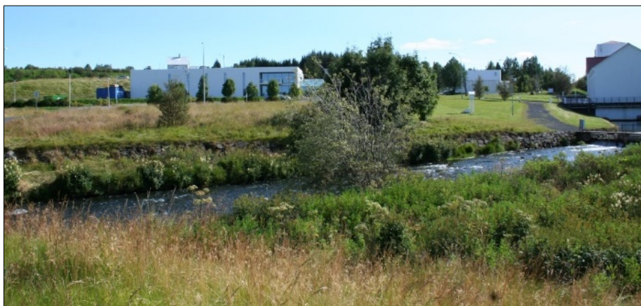
Mynd 129 Ártúnsvað (263-15), horft í austur. Búið er að hlaða upp árbakkana.
