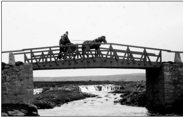
Mynd 59 Brúin yfir vestari kvíslina um 1910. Í baksýn er Búrfoss. Burðarbitar, brúargólf og handrið úr timbri. 167
