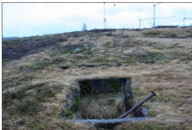
Mynd 32. Steypukassi (258-56), horft í suður.
