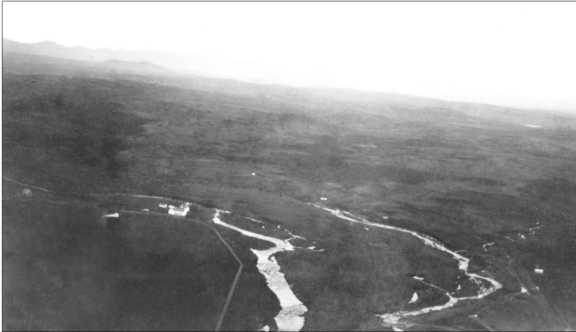
Mynd 20 Loftmynd tekin til suðausturs yfir Elliðaárnar, Blesugróf og Breiðholtsland árið 1930. Hús sem sjást talin frá vinstri eru starfsmannahús Rafmagnsveitunnar reist 1930, býlið Ártún og hús Rafstöðvarinnar sem reist voru 1920-1924. Sunnan ána sést móta fyrir Vatnsveituvegi og þar eru risin nokkur lítil hús eða bústaðir. Neðarlega, lengst til hægri, sést hús sem stóð við endann á skeiðvelli Fáks vestan Elliðaána (þar sem Reykjanesbraut liggur nú). Í fjarska, efst til vinstri, sést móta fyrir útvarpsmöstrum á Vatnsendahvarfi. 105
