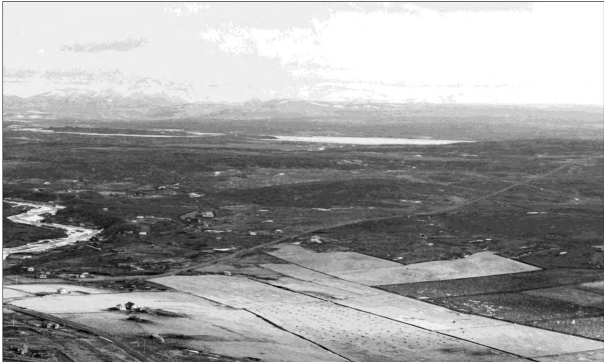
Mynd 21 Horft til suðausturs yfir Blesugróf og Breiðholtsland á ljósmynd frá 1946. Neðarlega til vinstri, neðan við Bústaðaveg, sést býlið Bústaðir. Ofan við það má greina svæðið þar sem braggahverfið New Mercur Camp stóð og byggðina sem risin er við Elliðaáarnar, í Blesugróf. Þar vestan með liggur Breiðholtsvegur eða Útvarpsstöðvarvegur og heldur áfram í gegnum Breiðholtsland alla leið upp að Vatnsendahvarfi. 108
