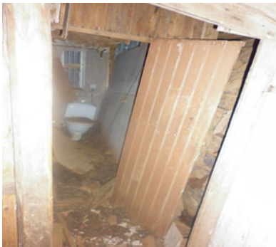
Mynd 11. Viðbygging/salerni 1982-1 (Ljósm. Þór Vigfússon 2013)
