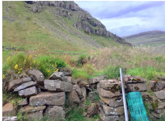
Mynd 26. Hlaða 1982-5, horft til N. (Ljós. MGL ágúst 2018)
