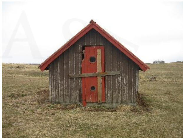
Hús yfir brunni 003, horft til norðausturs
