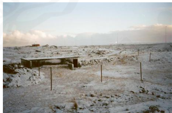
Hlaðinn vegur 093, horft til suðausturs
