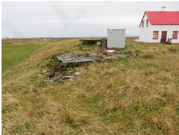
Leifar af hlöðu og fjósi sem eru sambyggðar Suðurgarði 006, horft til ASA
