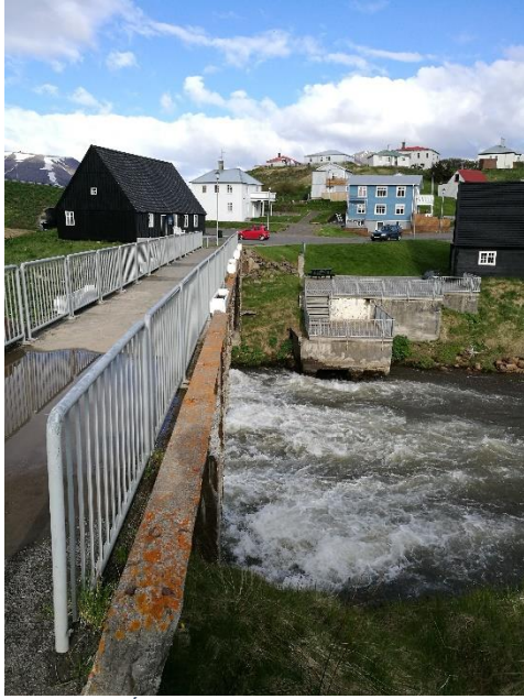
Mynd 37. Útsýnispallur við Hofsa ofan á gólfi rafstöðvarinnar [1187-36]. Neðri pallurinn er á sviðuðum stað og stöpull eldri brúarinnar [1887-11] á Hofsa.
