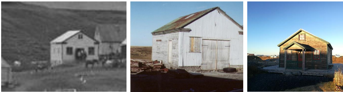
Mynd 17. Þrjár ljósmyndir af Poppverslun eða Vilhelmsbúð. Á myndinni lengst til vinstri er húsið nýreist sem verslunarhús eftir að gamla Poppverslunin brann, 1907. Á mynd í miðju sést húsið eftir að það var flutt upp á Bakkann vestan Skólavegar. Á myndinni lengst til hægri er húsið eins og það er nú í dag.
