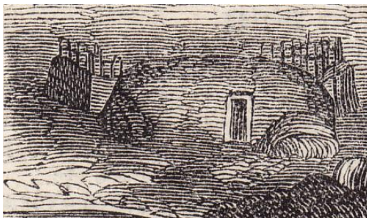
Mynd 27. Bygging sem sýnd er á teikningu frá 1857. Er líklega fjós [1887-21] sem brann um leið og Poppsveslun brann 1907. Teikn. frá 1857 í eigu HSk..
