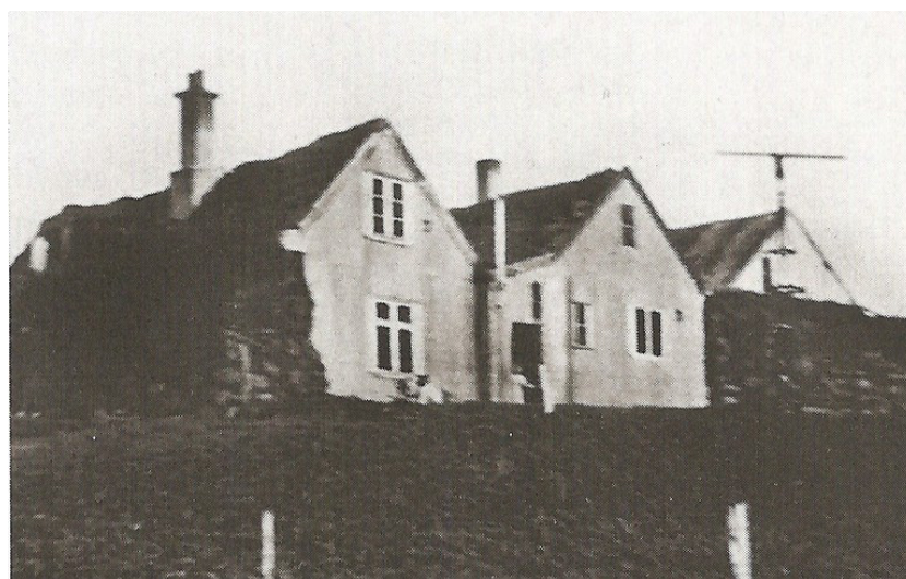
Mynd 2: Gamli bærinn í Kvígindisfirði, séð mót norðvestur. Frá vinstri eru tvær bæjarburstir með risi og skorstein. Húsið lengst til hægri er fjóshlaða. (Ljós. í eigu landeigenda.)
