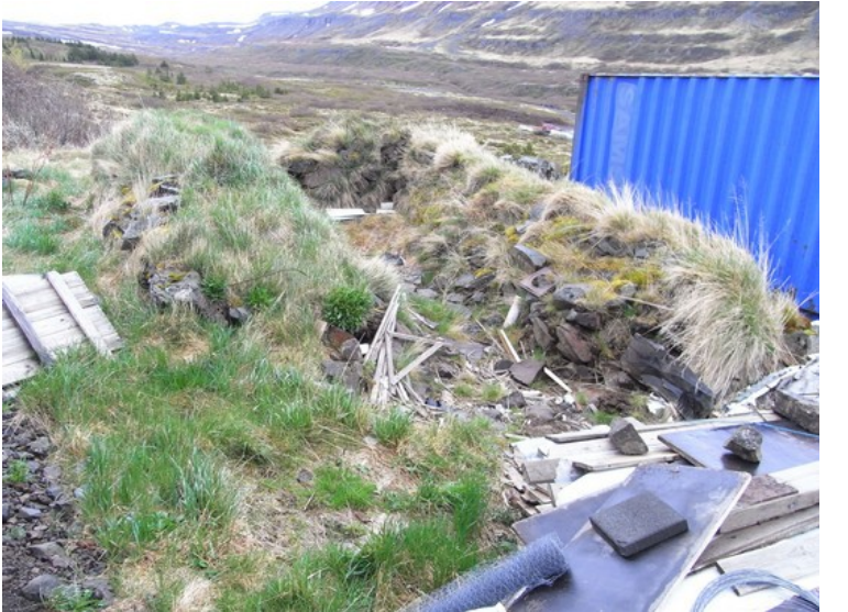
Mynd 42: Suðurendi tóftar nr. 1836-20 hefur skaðast vegna framkvæmda á lóð 2. (Mót norðaustur: Ljós. ÓLA)
