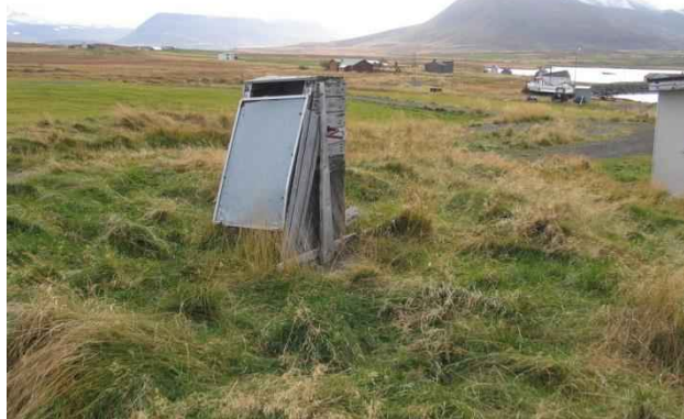
Mynd 131. Brunnurinn sem grafinn var heima við bæ í Vík. Lengst til hægri sést horn íbúðarhússins í Vík. Horft er til suðausturs.
